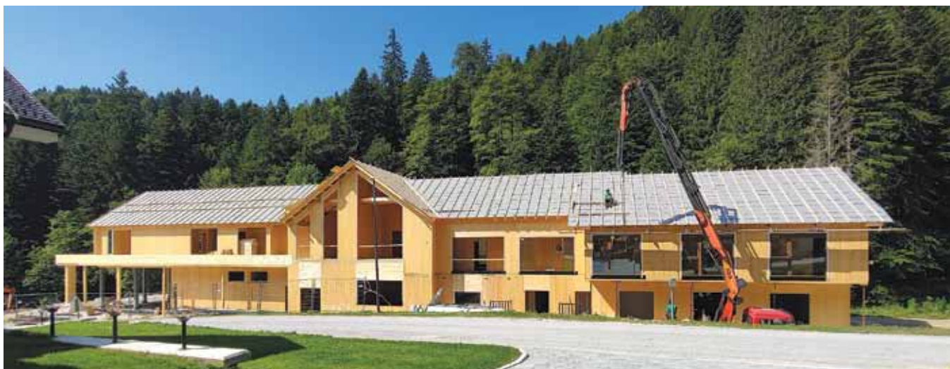
Turistički objekat u izgradnji na Rogli (Pohorje). CLT panele isporučuje Stilles, jedini proizvođač u Sloveniji.
